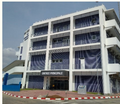
写真1:完工した母子保健棟
